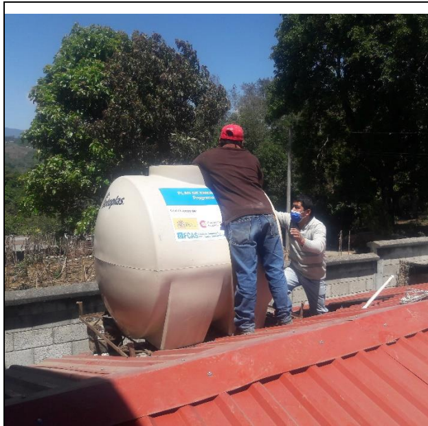
Instalación de tinaco de agua de 1000 litros, para abastecimiento de agua en el Instituto INED.
