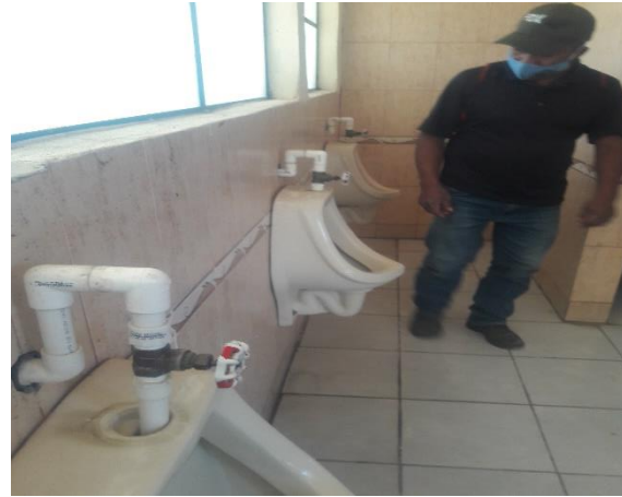
Inspección y arreglo de fugas de agua en los establecimientos.
