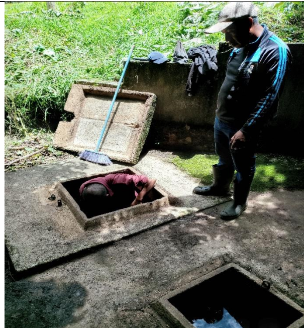
Limpieza de cajas de captaciones en nacimiento molinó.
