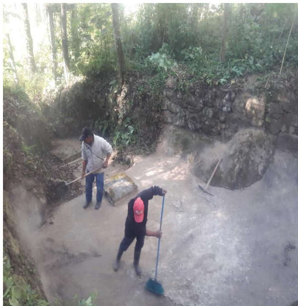
Limpieza de cajas de captaciones en nacimiento Pacorrall.
