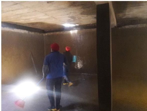
Lavado de tanques de distribución cabecera municipal
