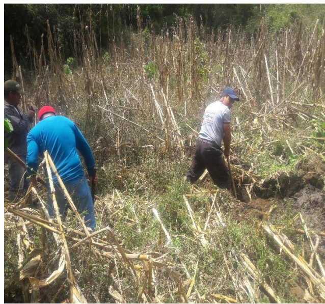
Verificación y reparación de líneas de conducción.
