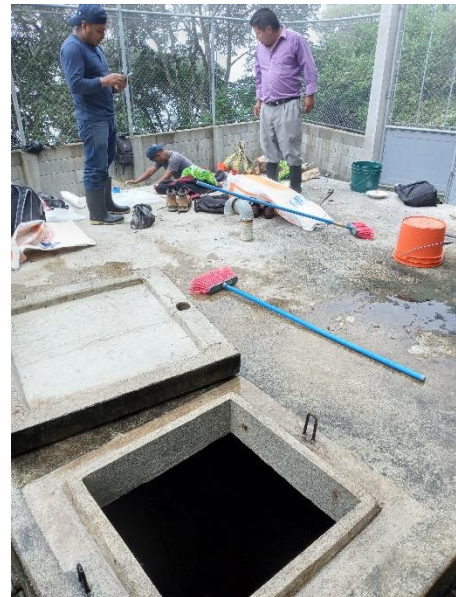
Lavado y desinfección de tanque de almacenamiento de agua, Caserío Chuipoj
