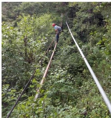
*Ilustración 27. Limpieza de línea de conducción de agua potable de la cabecera municipal.*
