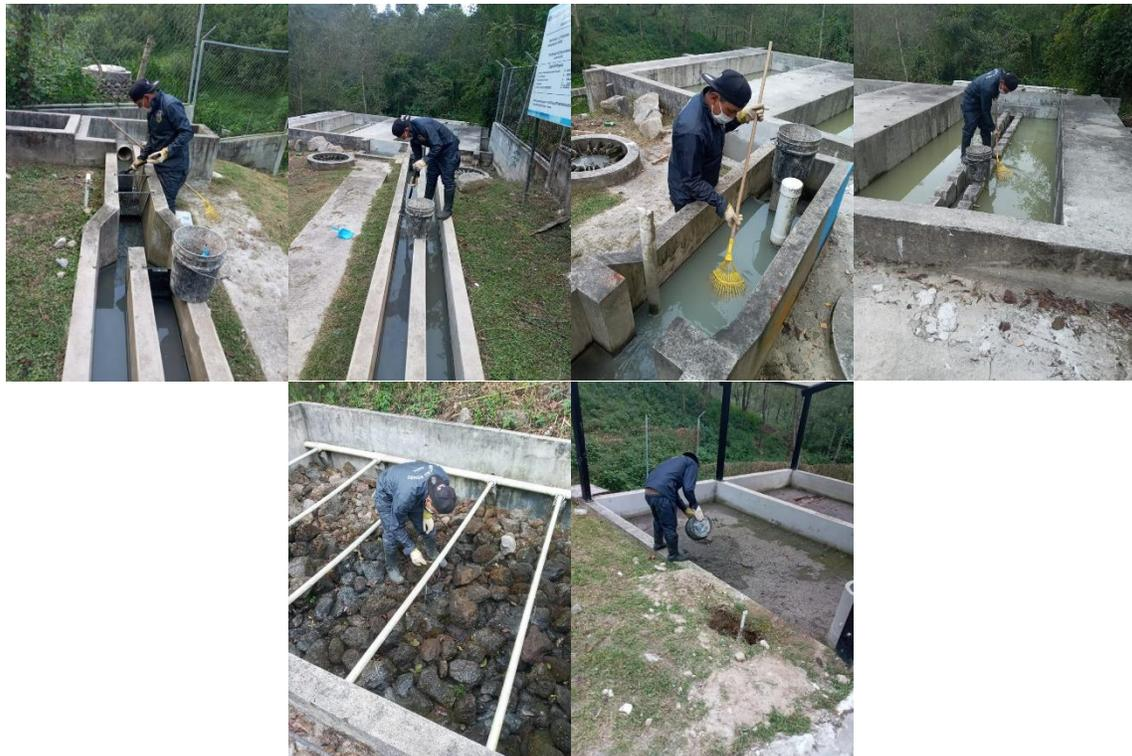
*Ilustración 20. Proceso de manejo del sistema de tratamiento de aguas residuales.*
